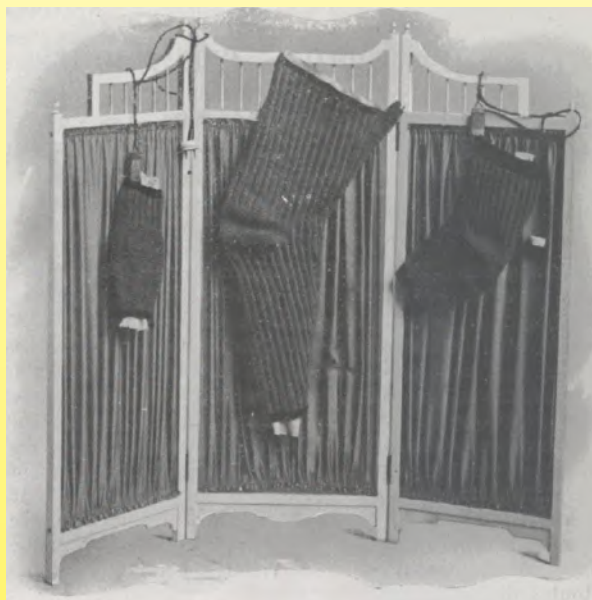
Ropa calefactada para uso médico por Herrgott, 1910 (Archivos de electricidad médica, 25 de agosto de 1910) Aquí podemos ver claramente la existencia de parches de cordón calefactor cosidos.
